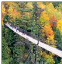
Pont piétonnier de St Anne-du-Nord
